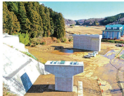
福島県0248号道路橋りょう整備(再復)工事(橋梁下部) 工期 / 平成28年12月26日～令和元年12月27日
