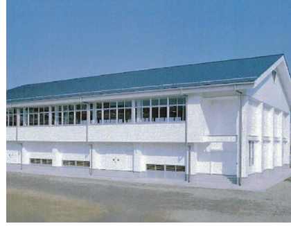
いわき市立錦中学校屋内運動場改築工事 工期 / 平成27年1月30日～平成29年3月31日
