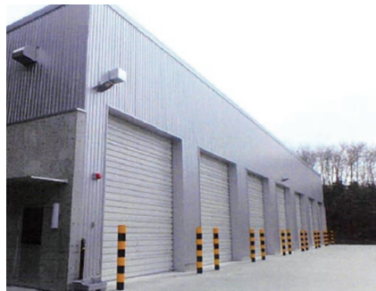
いわき市山田粗大ごみ処理施設ストックヤード新築工事 工期 / 令和2年7月8日～令和3年3月19日
