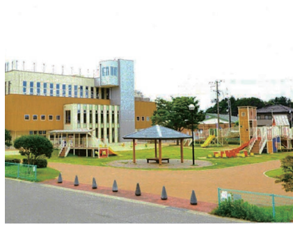
いわき市子ども元気センター新築工事 工期 / 平成26年12月12日～平成28年1月29日
