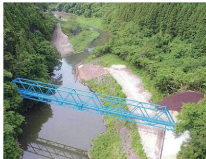
福島県033号鮫川水管橋耐震補強工事 工期 / 平成28年6月28日～平成29年7月14日
