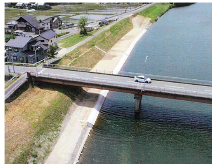
福島県0080号公共災害復旧工事(護岸工) 工期 / 令和2年3月30日～令和3年1月7日
