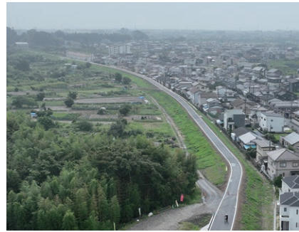
福島県0346号河川(交付)工事(築堤工) 工期 / 令和4年5月9日～令和5年9月29日
