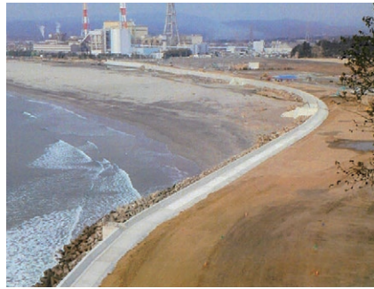
福島県0118号公共災害復旧(再復)工事(海岸) 工期 / 平成25年10月12日～平成29年3月31日
