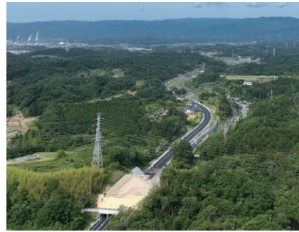
福島県小名浜道路工事(道路改良～舗装・標識・付属物) 工期 / 平成28年12月～令和7年7月
