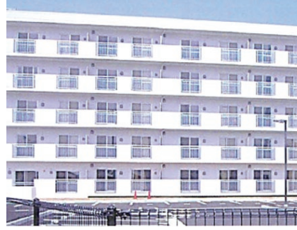
いわき市災害公営住宅佐藤団地新築工事(1工区) 工期 / 平成26年6月20日～平成27年9月30日
