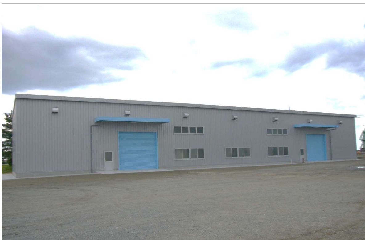
工事名:常磐共同火力株式会社 10号メンテナンス建屋建築工事 工 期:平成29年3月1日～平成29年9月15日
