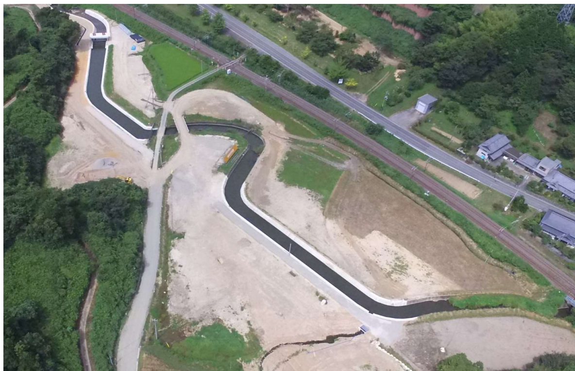
工事名:福島県 0132号 道路橋りょう整備(再復)工事(開削護岸) 工 期:平成30年9月18日~令和2年8月31日
