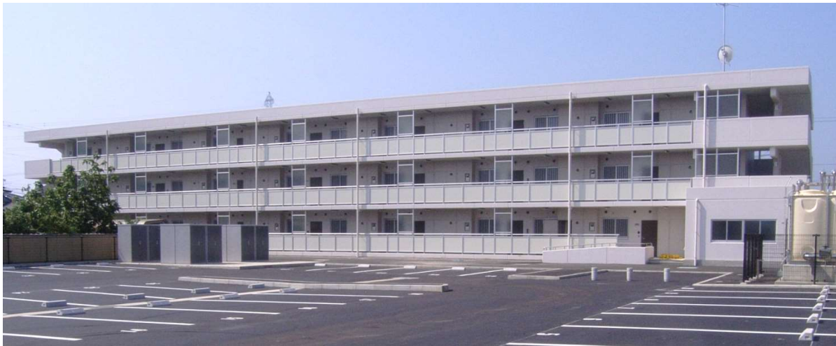
工事名:いわき市 災害公営住宅佐糠団地新築工事(2工区) 工 期:平成26年6月20日～平成27年9月30日
