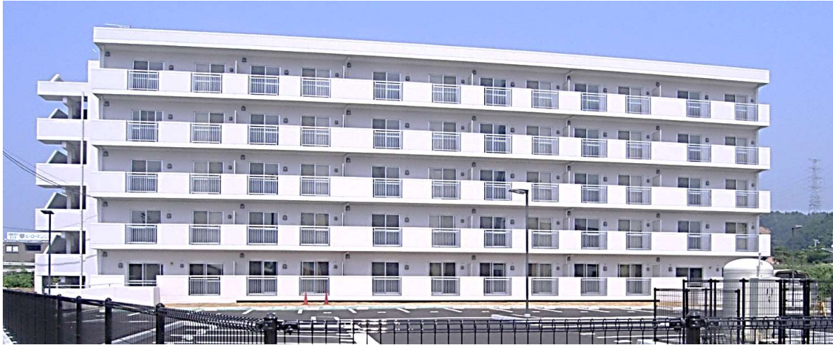
工事名:いわき市 災害公営住宅佐糠団地新築工事(1工区) 工 期:平成26年6月20日～平成27年9月30日
