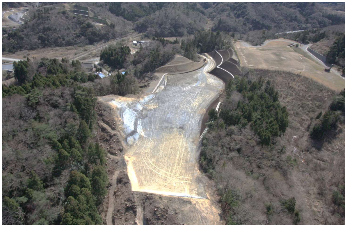
工事名:国交省:南作地区道路改良工事 工 期:平成21年7月17日～平成22年3月31日
