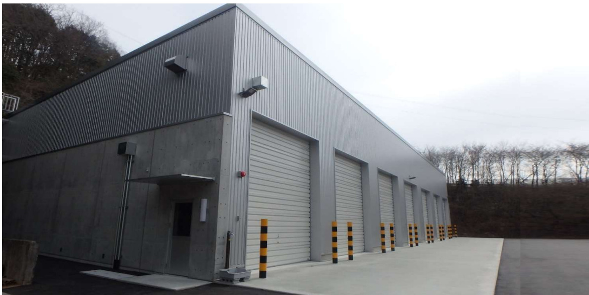
工事名:いわき市山田粗大ごみ処理施設ストックヤード新築工事 工期:令和2年7月8日～令和3年3月19日
