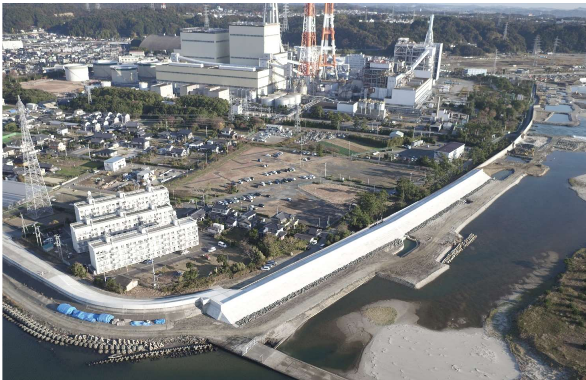
工事名:福島県 0418号 公共災害復旧(再復)工事(海岸) 工 期:平成27年3月23日～平成29年1月31日
