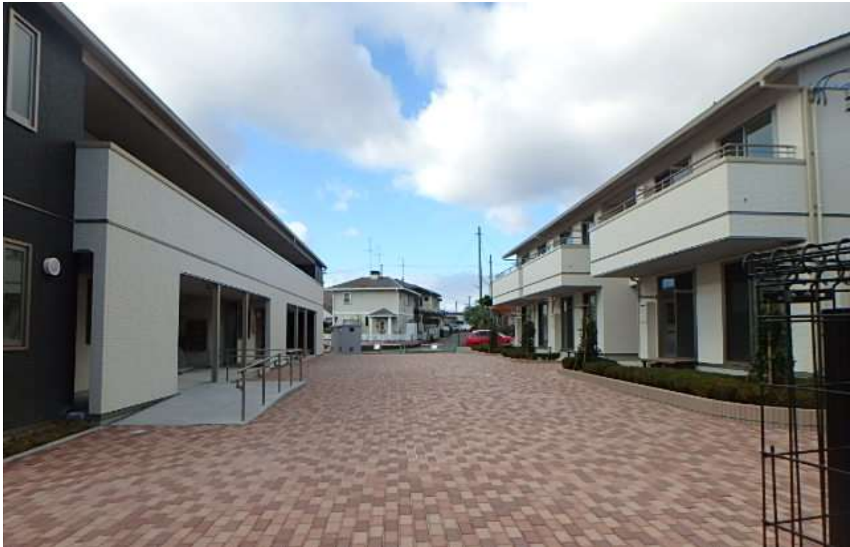
工事名:福島県 郡山復興住宅整備工事(買取型) 福島県第1号工事 工 期:平成27年9月1日～平成27年12月28日
