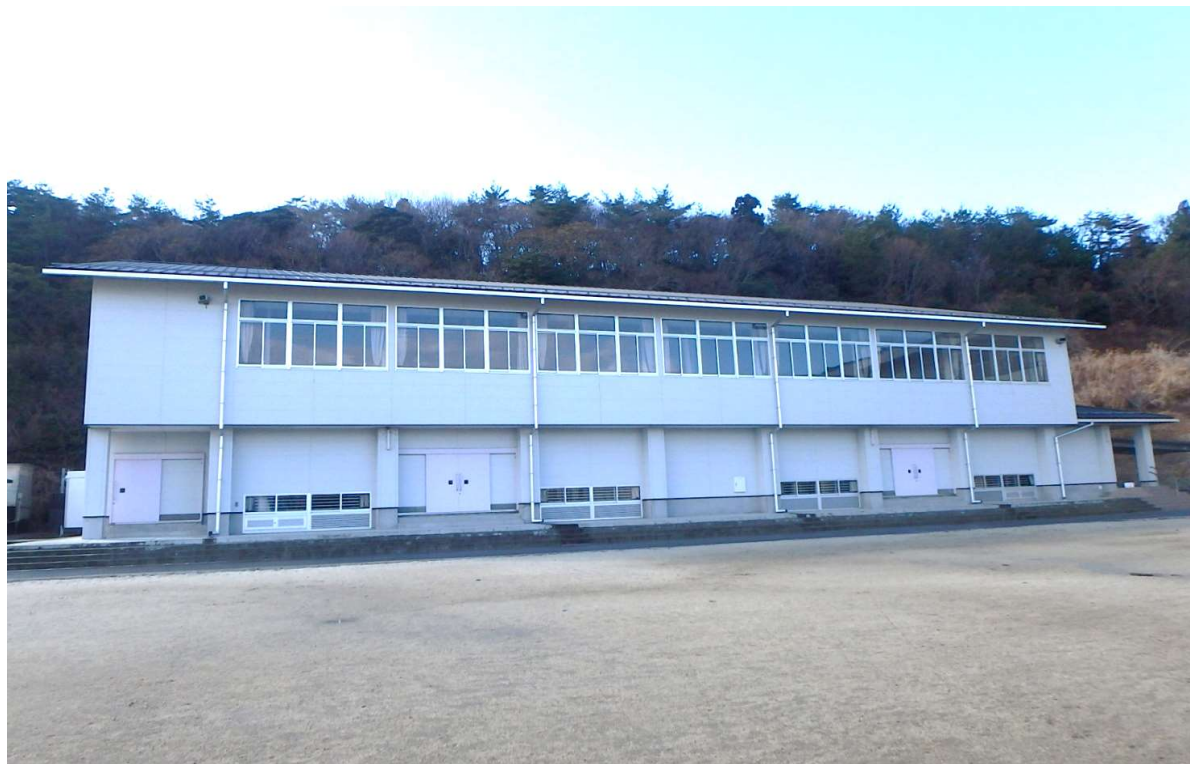
工事名: いわき市立藤間中学校屋内運動場改築工事 工 期: 平成26年6月20日～平成27年9月30日
