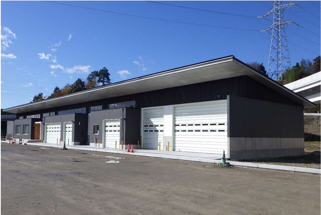
道路橋りょう整備(再復)工事(建築) いわき上三坂小野線
