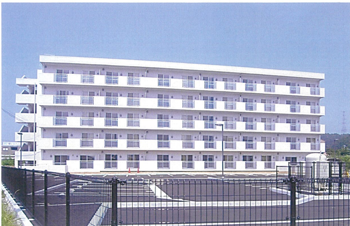
工事名:いわき市 災害公営住宅佐糠団地新築工事(1工区) 工 期:平成26年6月20日～平成27年9月30日
