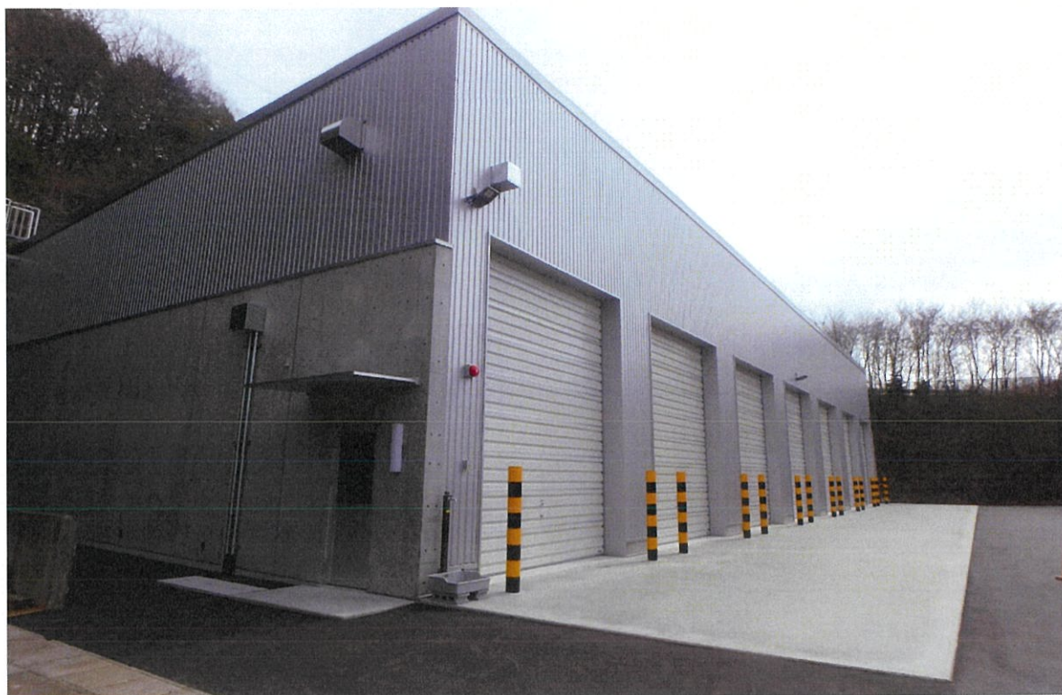
工事名: いわき市山田粗大ごみ処理施設ストックヤード新築工事 工期: 令和2年7月8日～令和3年3月19日
