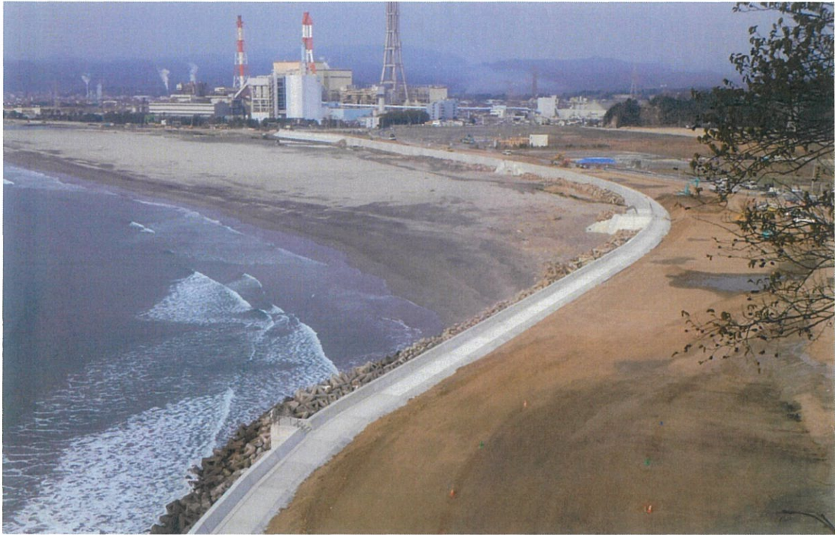
工事名: 福島県 0118号 公共災害復旧(再復)工事(海岸) 工 期: 平成25年10月12日～平成29年3月31日
