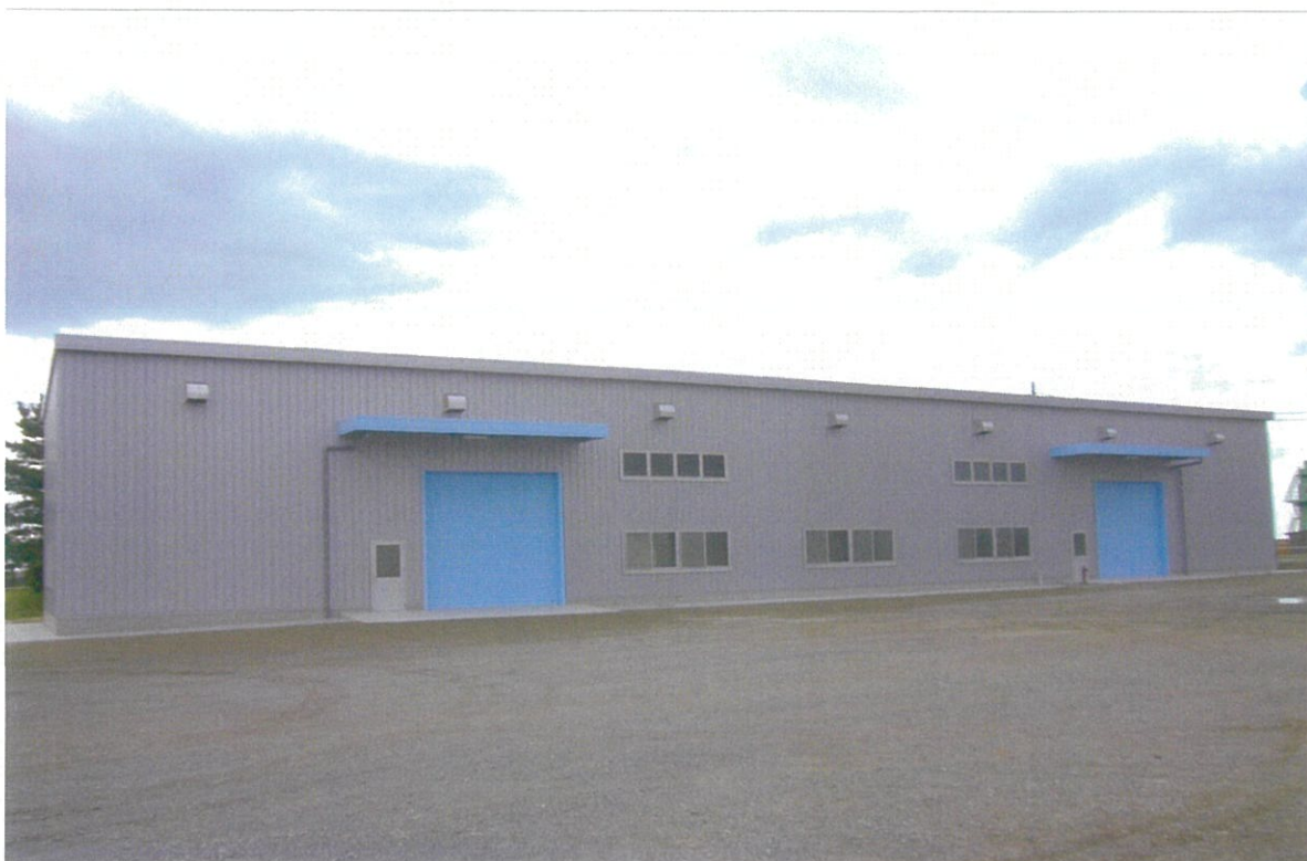
工事名: 常磐共同火力株式会社 10号メンテナンス建屋建築工事 工 期: 平成29年3月1日～平成29年9月15日
