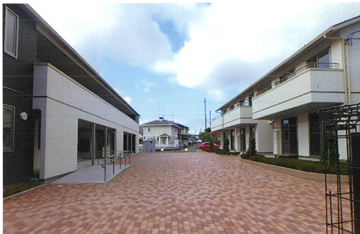
工事名: 福島県 郡山復興住宅整備工事(買取型) 福島県第1号工事 工期: 平成27年9月1日～平成27年12月28日
