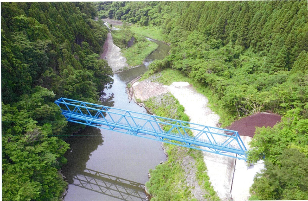
工事名:福島県 033号 鮫川水管橋耐震補強工事 工 期:平成28年6月28日～平成29年7月14日
