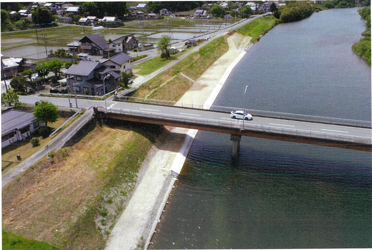
工事名:福島県 0080号 公共災害復旧工事(護岸工) 工 期:令和2年3月30日~令和3年1月7日
