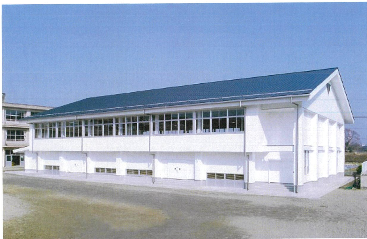
工事名:いわき市立錦中学校屋内運動場改築工事 工 期:平成27年1月30日～平成29年3月31日
