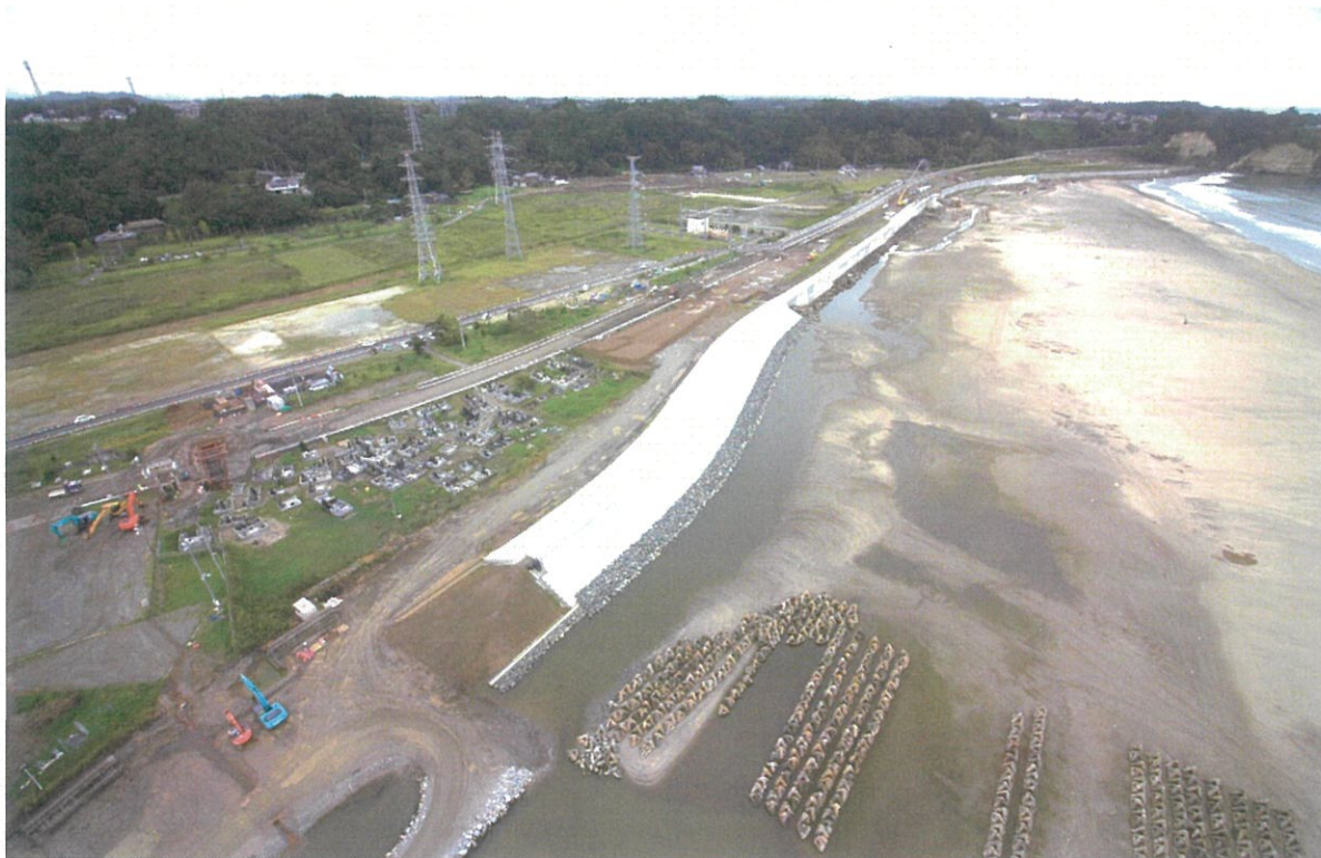
工事名:福島県 0417号 公共災害復旧(再復)工事(海岸) 工 期:平成27年3月16日~平成29年1月31日
