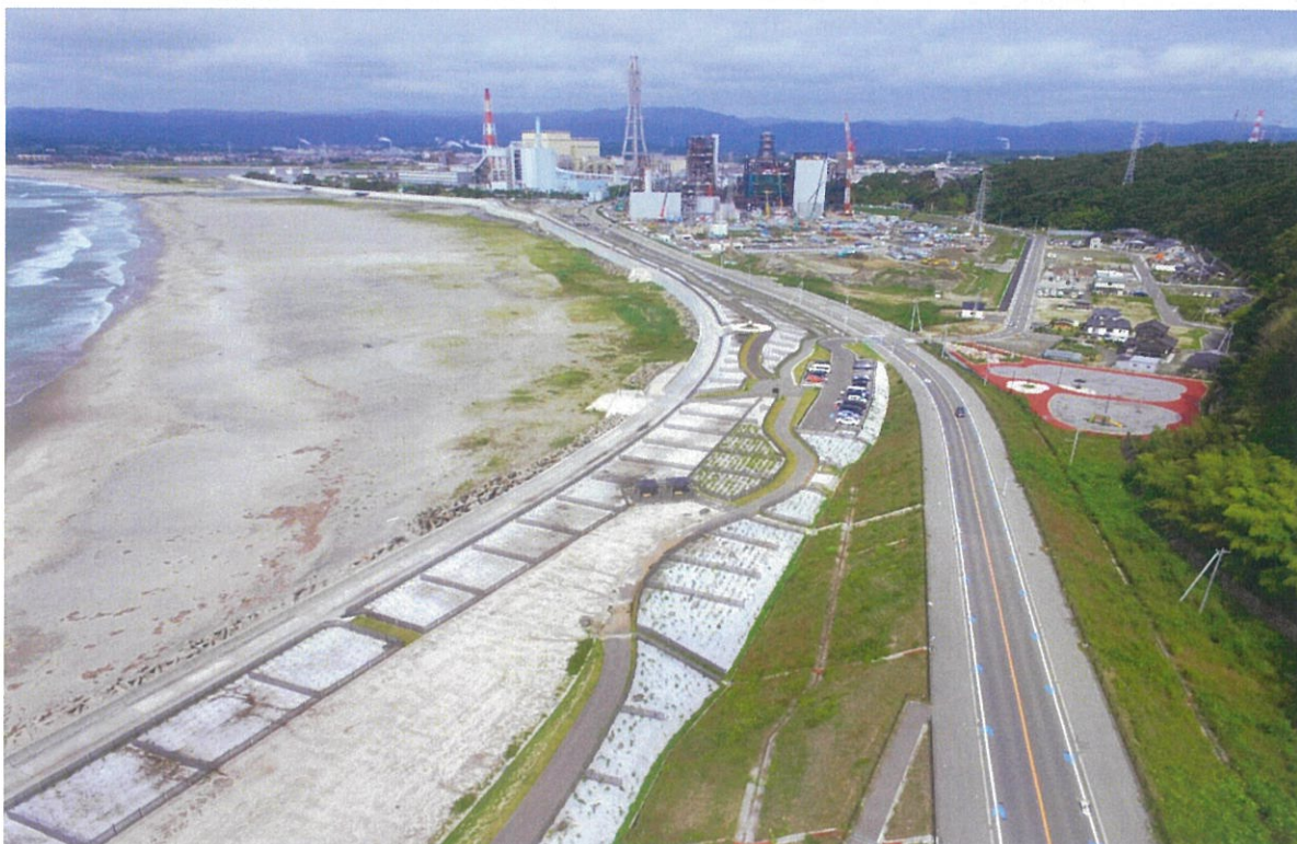
工事名:福島県 0305号 道路橋りょう整備(復交)工事(道路改良) 工 期:平成27年1月30日～平成29年3月31日
