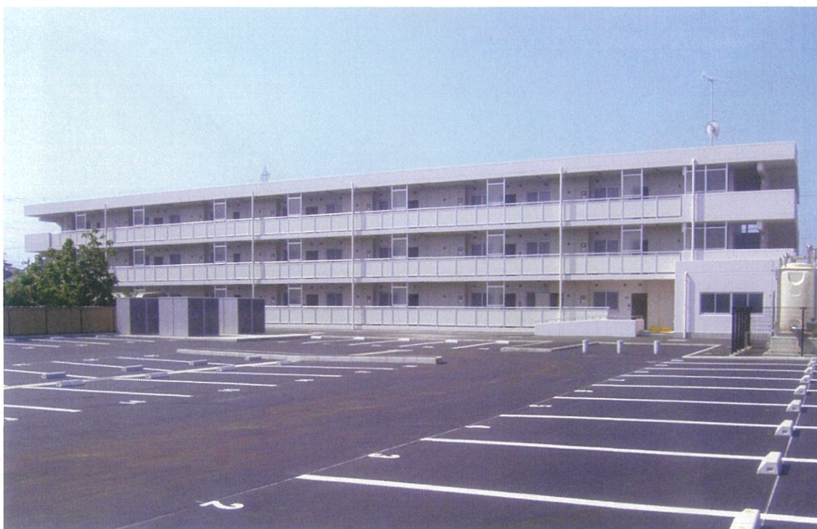
工事名:いわき市 災害公営住宅佐糠団地新築工事(2工区) 工 期:平成26年6月20日～平成27年9月30日
