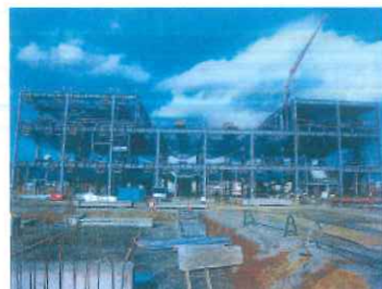
1F 入退管理室鉄骨一次加工
