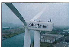
Vestas 1,990kW x 1基
