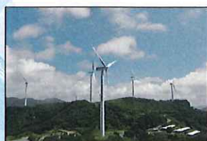
Vestas 1,750kW x 10基
