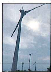
Enercon 2,300kW x 3基
