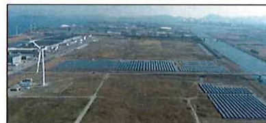
Vestas 3,300kW x 2基
